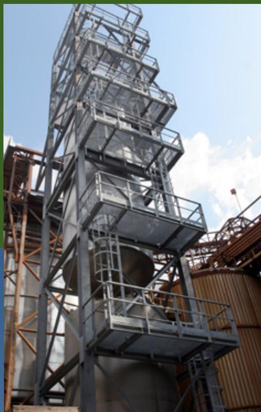
Abbattimento esausti contenenti idrogeno, 60.000 m<sup>3</sup>/h
